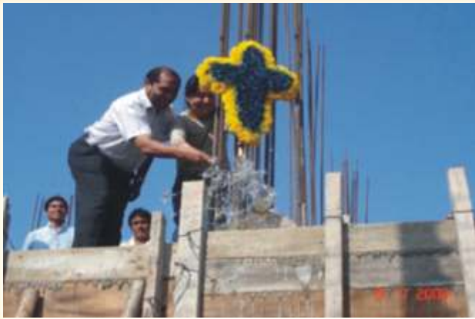
"Inaugurando el 1º Techo de la Torre Solmar"
